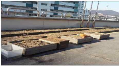
노후시설 보수 전
