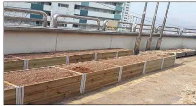
노후시설 보수 후
